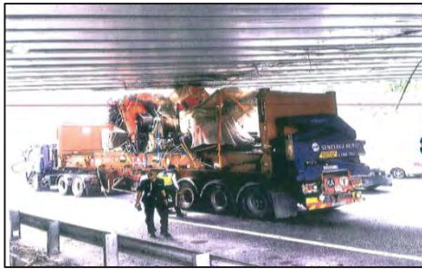
Jambatan NKVE - Kerosakan Pada Rasuk Jambatan (Sumber: Laporan KTMB)
