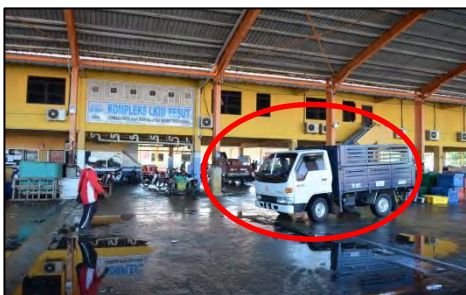
Kompleks Perikanan Kuala Besut, Terengganu - Kenderaan Memasuki Ruang Jeti Pendaratan Ikan yang Boleh Membahayakan Orang Awam (04.05.2017)
