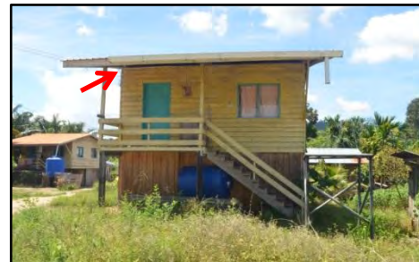
Kg. Alitang, Tongod - Rumah yang Telah Dipasang Talian Perkhidmatan Elektrik (18.05.2017)
