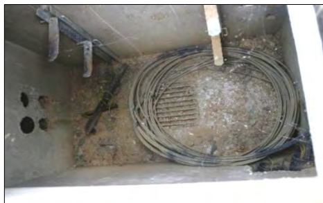
Dalam Pit Serta Semua Bilik TCR - Kabel Fiber Optik Sudah Uzur dan Kabel UTP Cat 6 Dibiarkan Tergantung dan Terbiar di Atas Lantai (11.07.2017)
