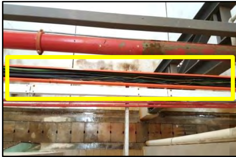
Bangunan Hangar - Pendawaian Elektrik yang Tidak Sempurna dan Tidak Selamat (10.07.2017)
