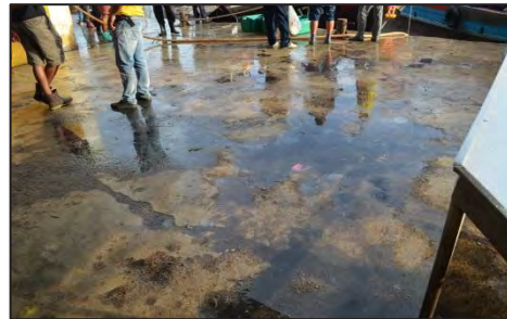
Kompleks Perikanan Kuala Perlis, Perlis - Air Bertakung di Jeti Pendaratan Ikan dan Lantai Tidak Rata (22.05.2017)
