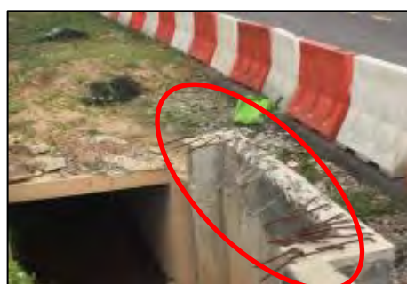
Persimpangan MITC - Stater Bar Telah Diturunkan ke Bawah (26.04.2017)
