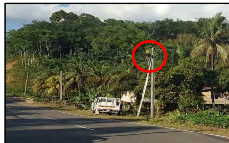
Jalan Linukuyan-Pinangah - Kerja Penyambungan Talian Elektrik Sedang Dilaksanakan (18.05.2017)
