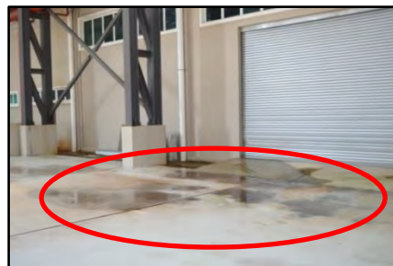
Bangunan Hangar - Kesan Dari Kebocoran Salur Air Hujan (gutter) (10.07.2017)
