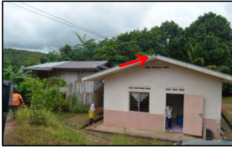
Kg. Bulieng, Tuaran - Rumah yang Telah Dipasang Talian Perkhidmatan Elektrik (08.05.2017)
