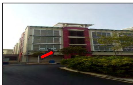
Koperasi WPSJ 167A - Bangunan yang Dibeli oleh Koperasi (07.03.2017)
