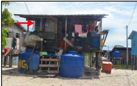
Kg. Pansuran, Pitas - Rumah yang Telah Dipasang Talian Perkhidmatan Elektrik (15.05.2017)
