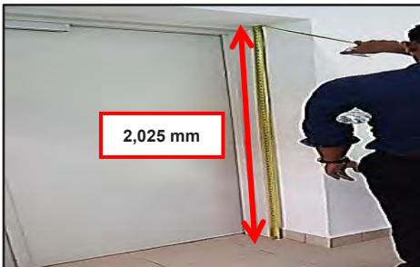
Tingkat 1, Bangunan CIQ, Jeti Kuah, Langkawi, Kedah - Ketinggian Pintu yang Dibina 2,025mm Tidak Mengikut Spesifikasi iaitu 2,100mm (14.11.2016)
