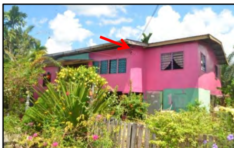
Kg. Labi, Beaufort - Rumah yang Telah Dipasang Talian Perkhidmatan Elektrik (25.04.2017)
