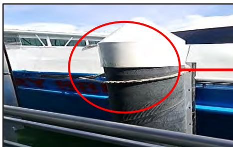
Jeti Kuah, Langkawi, Kedah - Tali Penambat Feri Disangkut Pada Fender Pile (29.03.2017)
