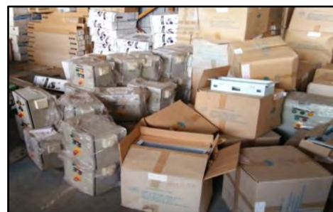
Stor Penyimpanan Barang (Material On Site) - Stater Panel yang Belum Dipasang dan Perlu Pengujian Semula (12.07.2017)
