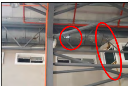
Bangunan Hangar - Kesan Dari Kebocoran Salur Air Hujan (gutter) (10.07.2017)
