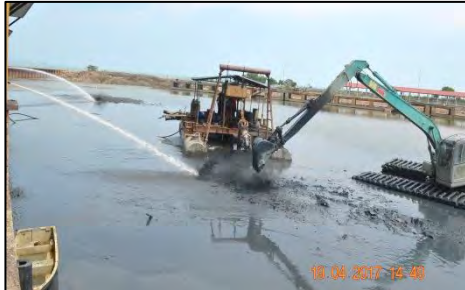
Kompleks Perikanan Sungai Duyong, Melaka - Kerja Mengorek Enapan Sedang Dijalankan (19.04.2017)
