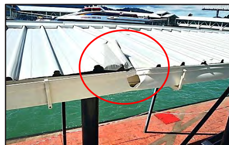
Labuhan 7, Jeti Kuah, Langkawi, Kedah - Kerosakan Gutter dan Bumbung Akibat Fender Pile yang Patah (06.09.2017)
