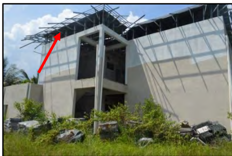
Wisma Perwira - Kerja Pemasangan Bumbung Masih Lagi Belum Selesai Menyebabkan Air Hujan Masuk ke Ruang Dalam Bangunan (10.07.2017)
