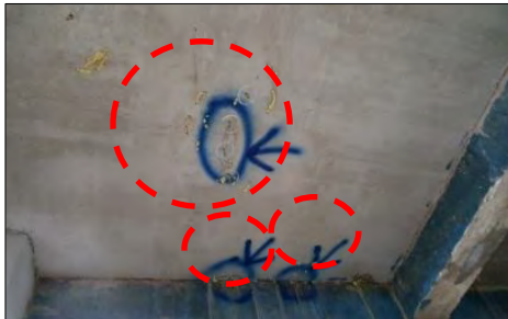
Residensi Hijauan Lumayan - Kebocoran Papak Siling Konkrit di Tempat Letak Kenderaan (09.05.2017)
