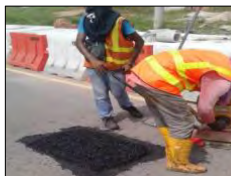
Persimpangan Peringgit - Pembaikan Pothole Dengan Menurap TAR (26.04.2017)
