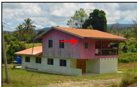
Kg. Lalapakon, Nabawan - Rumah yang Telah Dipasang Talian Perkhidmatan Elektrik (28.04.2017)
