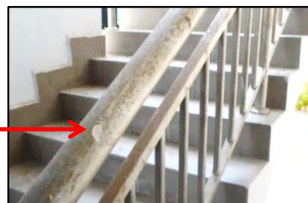
Sekolah Sistem - Terdapat Kecacatan Pada Stainless Steel Hand Railing (10.07.2017)
