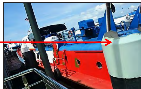
Jeti Kuah, Langkawi, Kedah - Tali Penambat Feri Disangkut Pada Fender Pile dan Menyebabkan Kerosakan (06.09.2017)
