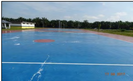
Institut Kemahiran Belia Negara (IKBN), Tanah Merah - Gelanggang Bola Jaring dan Bola Tampar - Keretakan Pada Permukaan Lantai (18.04.2017)
