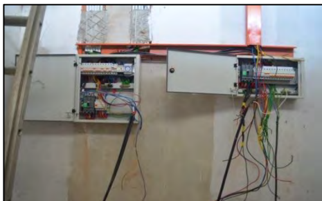
PPU Simpang Bongkol, Pitas - Pendawaian Dalam Bangunan PPU Belum Siap Sepenuhnya (15.05.2017)
