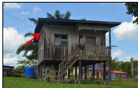
Kg. Nandangan, Nabawan - Rumah yang Telah Dipasang Talian Perkhidmatan Elektrik (28.04.2017)
