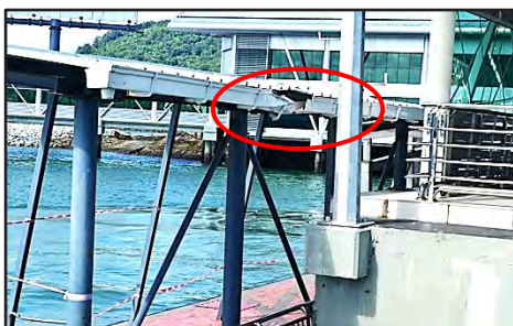
Labuhan 7, Jeti Kuah, Langkawi, Kedah - Kerosakan Gutter dan Bumbung Akibat Fender Pile yang Patah (06.09.2017)
