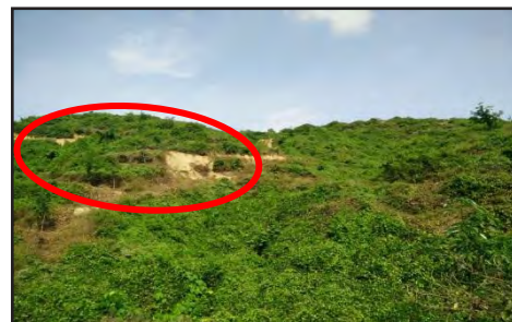
Blok 4, Ladang Sejahtera Ganda - Runtuhan Teres Ladang yang Baru Berlaku Tidak Terkecuali di Kawasan yang di Tumbuhi Rumpai dan Penutup Bumi yang Masih Hidup (08.02.2017)
