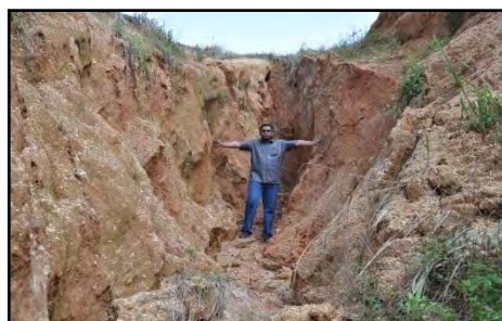
Blok 4, Ladang Sejahtera Ganda - Keadaan Jalan Cawangan Ladang yang Rosak Teruk Kerana Hakisan yang Mempunyai Kedalaman Melebihi 8 Kaki (08.02.2017)
