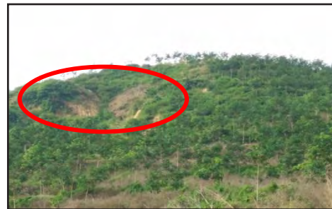
Blok 2, Ladang Sejahtera Ganda - Keadaan Runtuhan Teres yang Berlaku di Tengah-Tengah Ladang Pokok Getah (08.02.2017)
