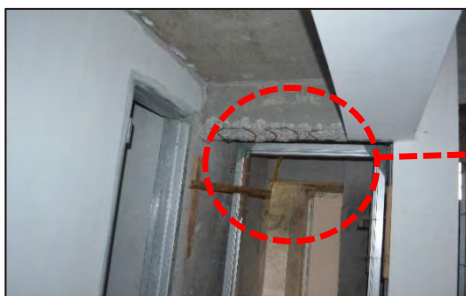
Stesen Terminal Skypark, Subang Aras Bawah - Rasuk Dipecahkan Sehingga Besi Tetulang Terdedah (11.01.2017)
