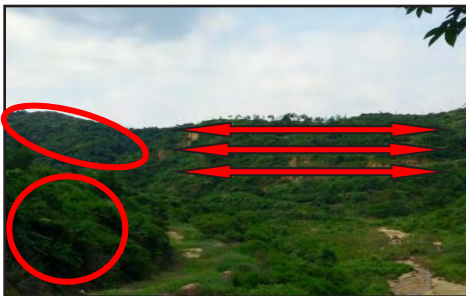
Blok 3, Ladang Sejahtera Ganda - Keadaan Bekas Runtuhan Teres Ladang yang Melebihi Darjah Kecerunan yang Ditetapkan (08.02.2017)
