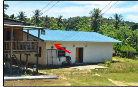
Kg.Sarang, Kota Belud - Rumah yang Telah Dipasang Talian Perkhidmatan Elektrik (09.05.2017)
