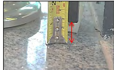
Pintu Ketibaan Antarabangsa Bangunan CIQ, Jeti Kuah, Langkawi, Kedah - Jarak Antara Bahagian Bawah Pintu Gelangsar Automatik Dengan Aras Lantai yang Tidak Mengikut Spesifikasi (16.11.2016)
