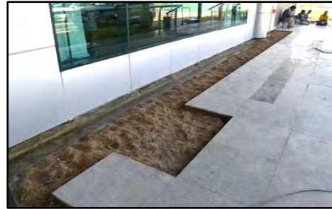
Kawasan Luar Bangunan CIQ, Jeti Kuah, Langkawi, Kedah - Kerja-Kerja Penukaran Lantai Granite Sedang Dibuat (06.09.2017)
