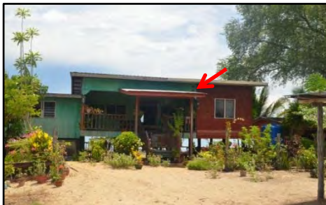
Kg.Malubang, Pitas - Rumah yang Telah Dipasang Talian Perkhidmatan Elektrik (15.05.2017)
