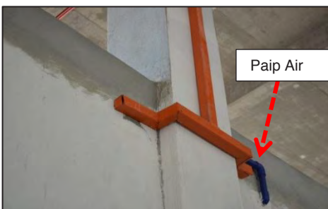
Terminal Skypark Subang Guard (Aras Bawah) - Paip Air Berada di Bahagian Atas Trunking Elektrik (10.01.2017)
