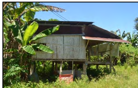
Kg. Sarang, Kota Belud - Rumah Tidak Berpenghuni (09.05.2017)
