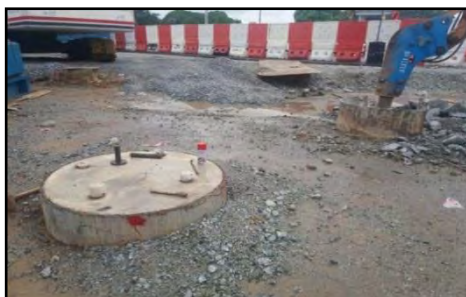
Persimpangan Peringgit - Ketidakseragaman Konkrit Pada Cerucuk No. 2A/2.3 (26.04.2017)
