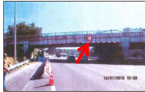
Jambatan NKVE - Papan Tanda Menunjukkan Amaran Ketinggian Maksimum 4.5 Meter (Sumber: MOT - 10.01.2015)
