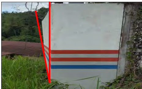
Kg. Patian Tengah, Tenom - Binaan Konkrit Pencawang Elektrik Melengkung (26.04.2017)
