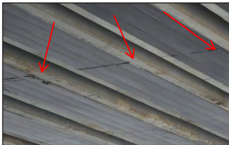
Jambatan NKVE - Kerosakan Pada Rasuk Jambatan (Sumber: Laporan KTMB)
