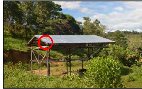
Kg. Kondis, Kota Belud - Rumah Belum Siap Telah Dipasang Talian Perkhidmatan (09.05.2017)
