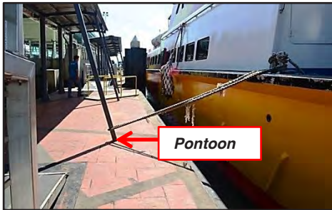
Jeti Kuah, Langkawi, Kedah - Tali Penambat Feri Disangkut Pada Tiang Bumbung Pontoon (06.09.2017)
