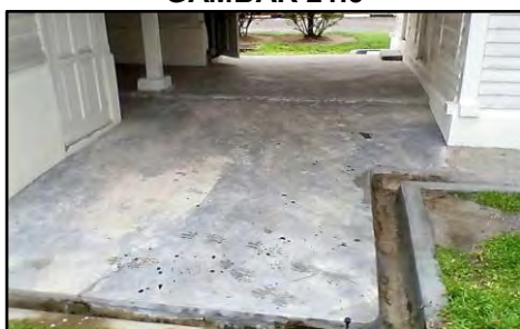
Rumah Za'ba - Kerja Lantai Berlepa Dibuat Kurang Daripada Kuantiti Dalam Spesifikasi (15.06.2017)
