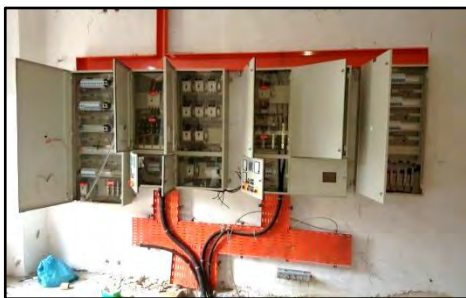
Bangunan Hangar - Pendawaian Elektrik yang Tidak Sempurna dan Tidak Selamat (10.07.2017)
