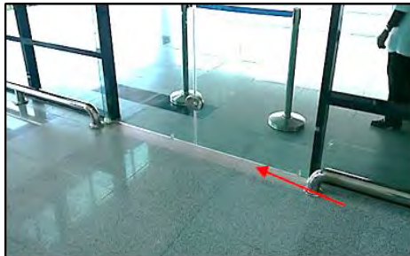
Pintu Ketibaan Antarabangsa Bangunan CIQ, Jeti Kuah, Langkawi, Kedah - Jarak Antara Bahagian Bawah Pintu Gelangsar Automatik Dengan Aras Lantai yang Tidak Mengikut Spesifikasi (16.11.2016)
