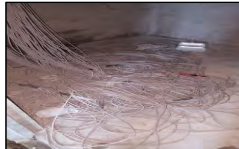
Dalam Pit Serta Semua Bilik TCR - Kabel Fiber Optik Sudah Uzur dan Kabel UTP Cat 6 Dibiarkan Tergantung dan Terbiar di Atas Lantai (11.07.2017)
