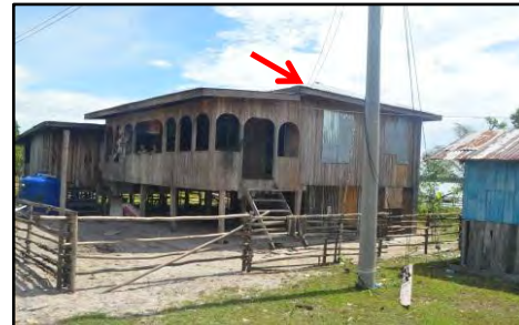
Kg. Tiga Tarok, Pitas - Rumah yang Telah Dipasang Talian Perkhidmatan Elektrik (15.05.2017)
