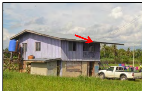
Kg. Kota Ayangan, Keningau - Rumah yang Telah Dipasang Talian Perkhidmatan Elektrik (27.04.2017)
