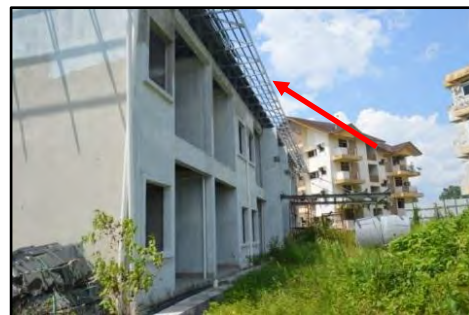
Wisma Perwira - Kerja Pemasangan Bumbung Masih Lagi Belum Selesai Menyebabkan Air Hujan Masuk ke Ruang Dalam Bangunan (10.07.2017)
