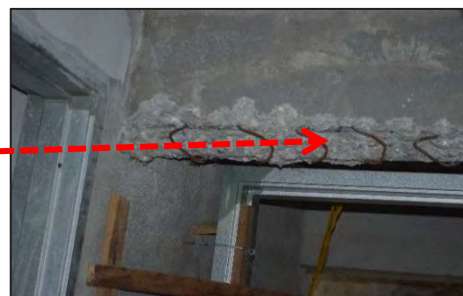
Stesen Terminal Skypark, Subang Aras Bawah - Rasuk Dipecahkan Sehingga Besi Tetulang Terdedah (11.01.2017)
