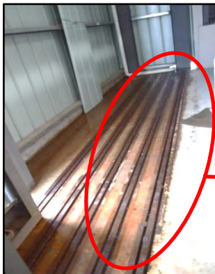
Bangunan Hangar - Pengaratan Pada Keluli Gelangsar Pintu Hangar (10.07.2017)
