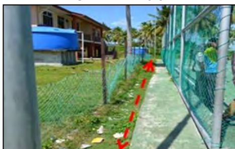
Gelanggang Futsal Kg. Sumandi, Semporna, Sabah - Longkang Tanah Liat 225 mm dan Sump Tidak Dibuat Seperti yang Ditetapkan (22.12.2016)
